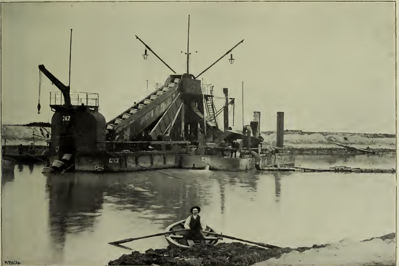
Abbildg. 19. Schwimmender Nassbagger mit Spülvorrichtung.
